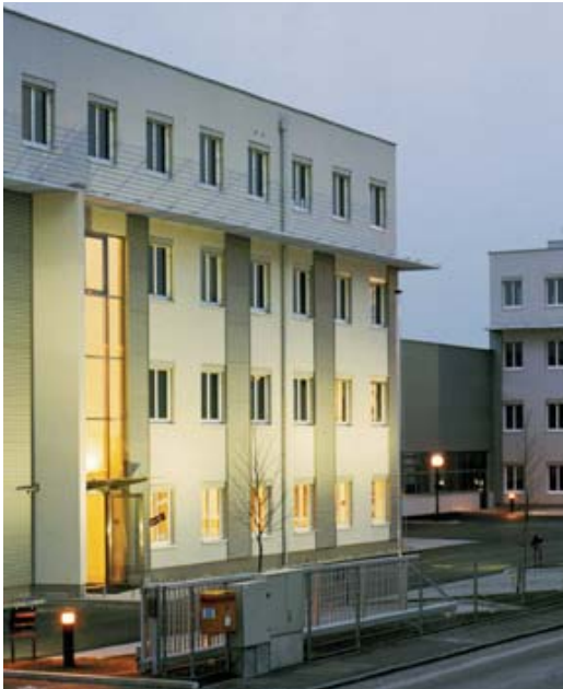
Büro- und Lagerräumlichkeiten sind im gleichen Gebäude
