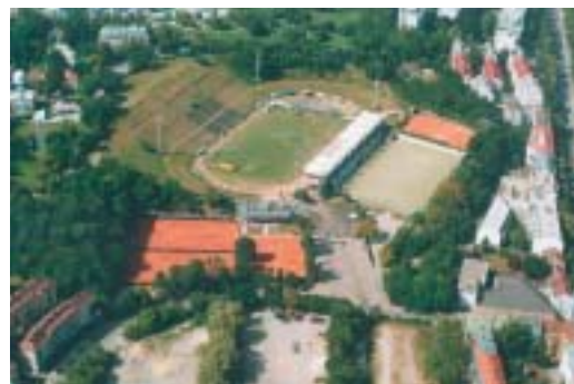
Nächstes Jahr ist voraussichtlicher Baubeginn des Wohnprojekts Hohe Warte.
