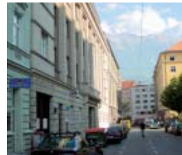
Das historische Gebäude beherbergt die OeNB und den Münze Österreich-Shop
