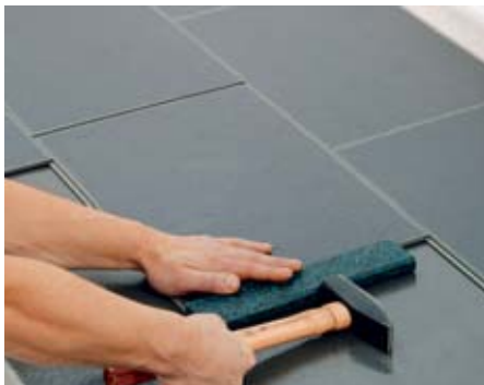
Dank der Verlegetechnik entsteht eine ...
